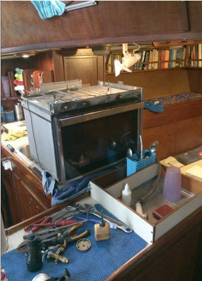
Reparatie van de oven in de kombuis
